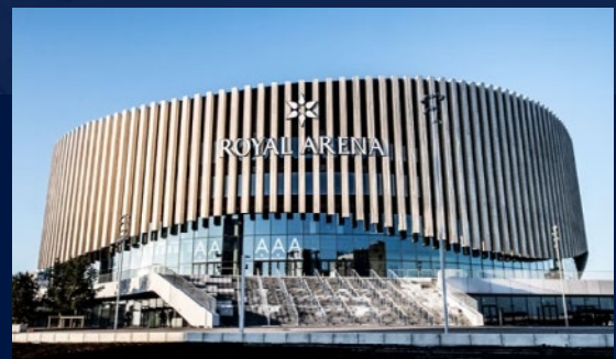
Finaaliottelut pelataan Kööpenhaminassa Royal Arenalla.
